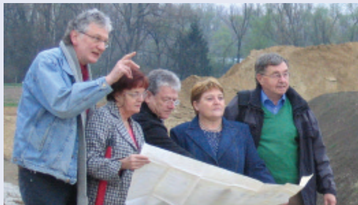
SPD-Ortsbeiratsmitglieder (v.l.n.r.: Gerhard Strotkötter, Helga Kasten, Paul Stenner und Cläre Holzkämper) besichtigen mit dem SPD-Umweltexperten Prof. Gerfried Gebert die Bauarbeiten am Polder.
